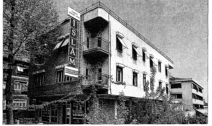
Türkiye Diyanet Vakfı İslâm Ansiklopedisi hizmet binası - Bağlarbaşı / İstanbul
